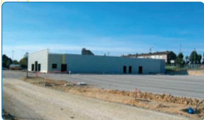
Bientôt, la construction du magasin ED sera terminée.
